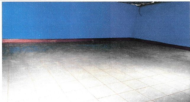
Foto 4: sustitucion de piso de ceramica
