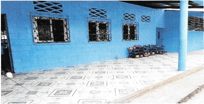
Foto. Sustitucion de ventanas PVC
