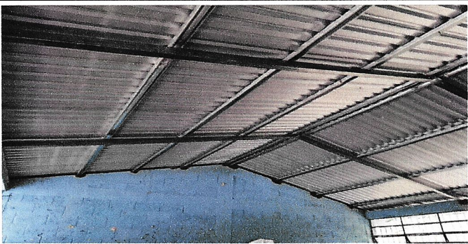
Foto 3: Sustitucion de lamina troquelada
