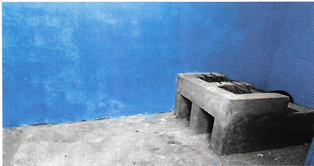
Foto 6: Reparacion de cocina
