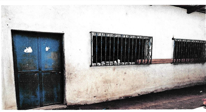
Foto 2: sustitucion de puertas y balcones
