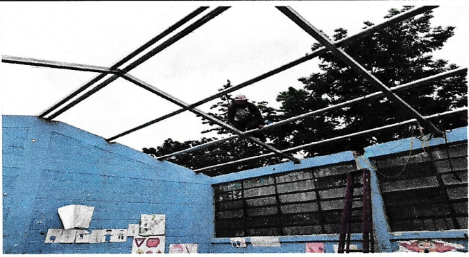
Foto1: Sustitucion de estructura de metal
