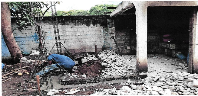
Foto 6: Reparacion de cocina
