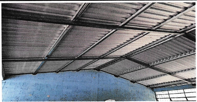
Foto 3: Sustitucion de lamina troquelada
