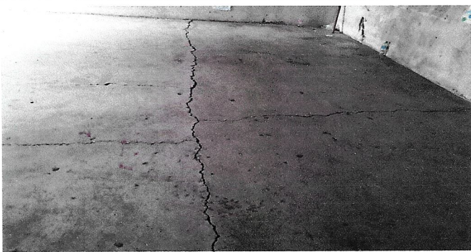
Foto 2: Sustitución de piso de cerámica
