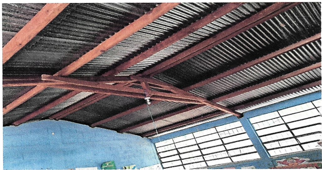
Foto 3: Sustitución de cubierta de almina por lamina troquelada cal. 26
