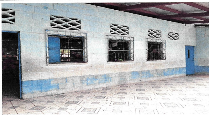
Foto 4: sustitución ventanas pvc frente y atrás
