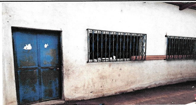
Foto 6: Reparacion de puertas y balcones
