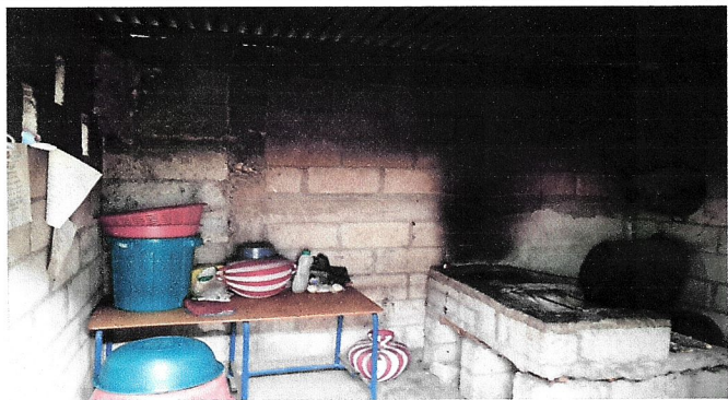
Foto1: Reparación de cocina
