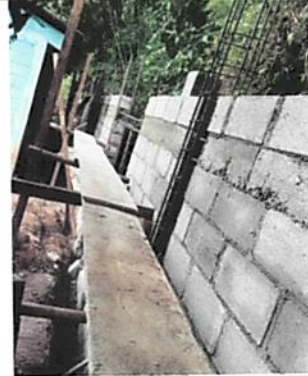
Foto 4: REPARACIÓN DEL MURO PERIMETRAL
