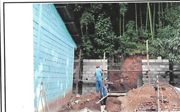
Foto 5: REPARACIÓN DEL MURO PERIMETRAL
