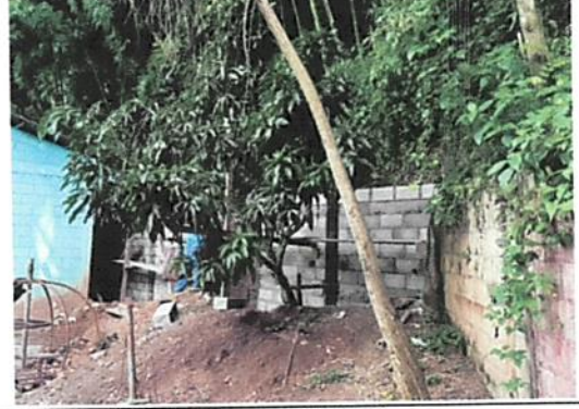
Foto 2: REPARACIÓN DEL MURO PERIMETRAL
