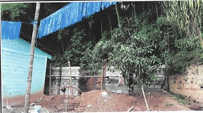
Foto1: .REPARACIÓN DEL MURO PERIMETRAL
