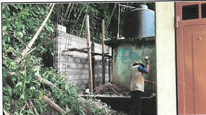
Foto 3: REPARACIÓN DEL MURO PERIMETRAL
