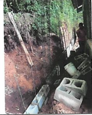
Foto 6: REPARACIÓN DEL MURO PERIMETRAL
