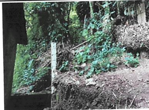
Foto 2: REPARACIÓN DEL MURO PERIMETRAL
