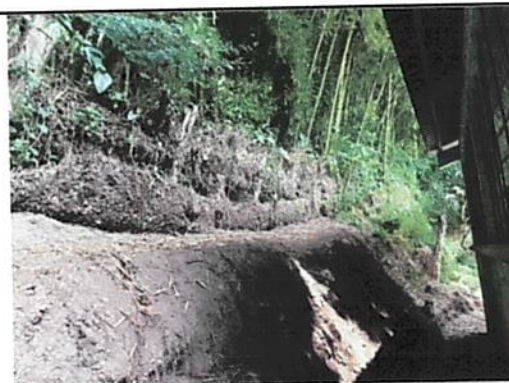
Foto 4: REPARACIÓN DEL MURO PERIMETRAL
