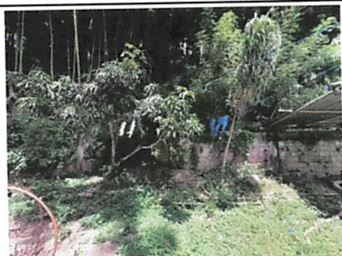
Foto 5: REPARACIÓN DEL MURO PERIMETRAL
