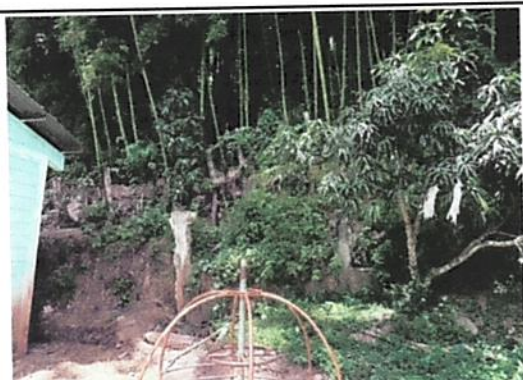
Foto 3: REPARACIÓN DEL MURO PERIMETRAL
