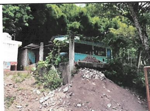
Foto 6: REPARACIÓN DEL MURO PERIMETRAL
