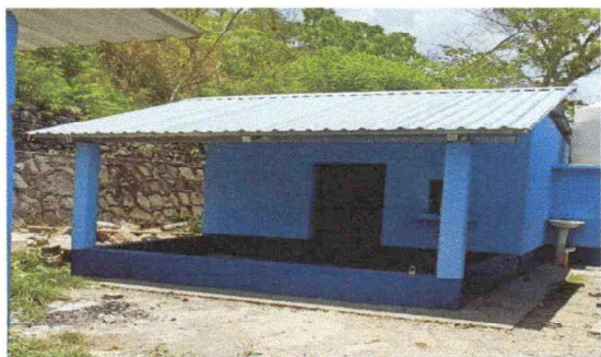
Foto 3: Sustrucción de lámina y estructura de madera por metal en la cocina.
