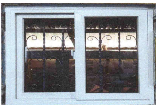
Foto 5: Sustrucción de ventana de metal.
