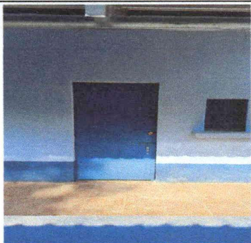
Foto 1: Sustrucción de puerta de cocina
