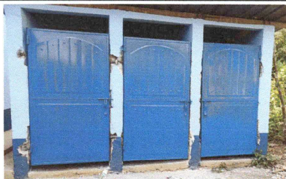
Foto 4: Sustrucción de puerta de módulo de baños.
