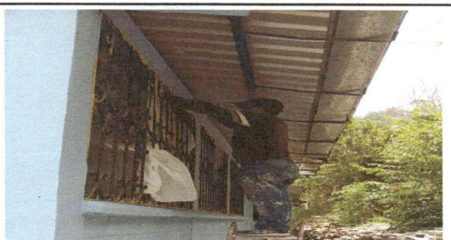
Foto 6: Mantenimiento correctivo y preventivo de Balcón
