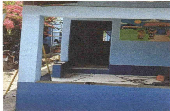
Foto 2: Sustrucción de puerta de aula
