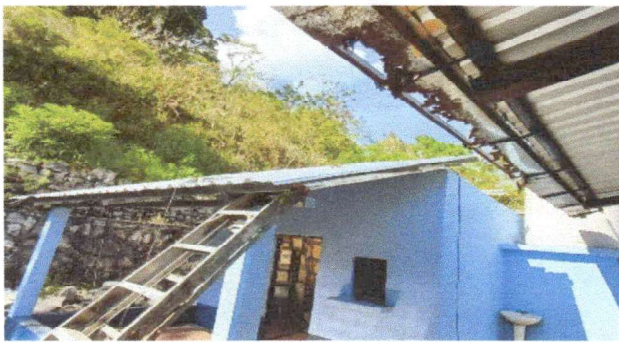
Foto 3: Sustrucción de lámina y estructura de madera por metal en la cocina.
