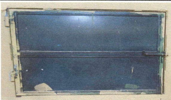
Foto 5: Sustrucción de ventana de metal.
