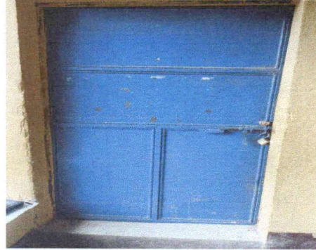
Foto 2: Sustrucción de puerta de aula
