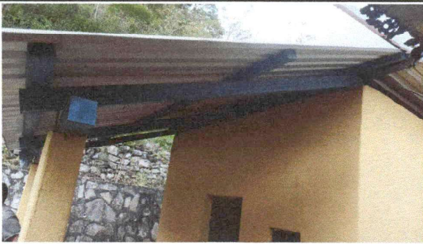
Foto 3: Sustrucción de lámina y estructura de madera por metal en la cocina.
