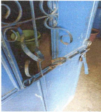
Foto 1: Sustrucción de puerta de cocina
