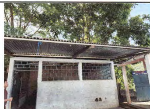
FOTO. 3 Instalación de ventanas.
