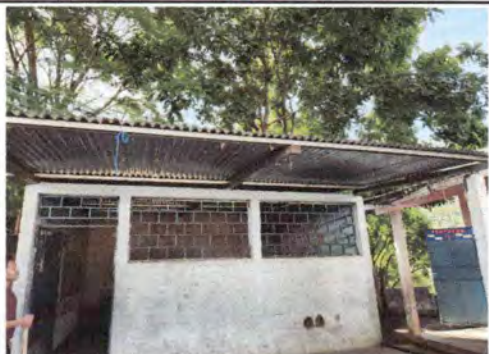
FOTO. 1 Sustitución de lámina por lamina troquelada y soporte de madera por metal.
