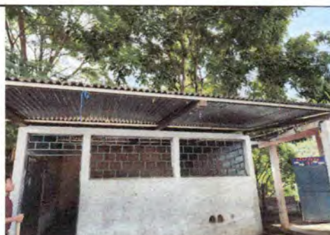
FOTO 6. Instalación de sistema eléctrico.
