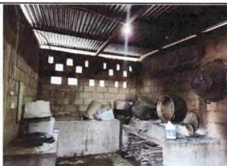
FOTO 5. Sustitución de meson de concreto por meson de azulejo
