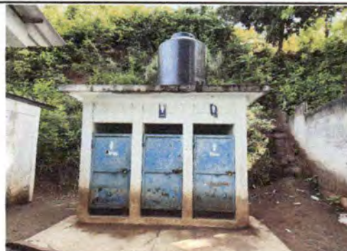
FOTO. 2 Mantenimiento a estructura de servicios sanitarios.
