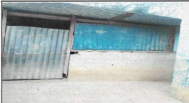
Foto 1: Colocación de puerta y ventana.
