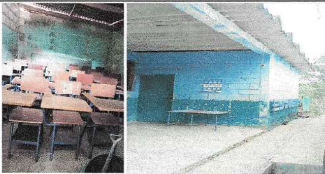
Foto 3: Pintura de interior y exterior.
