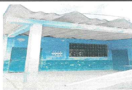
Foto 2: Sustitución de lámina.
