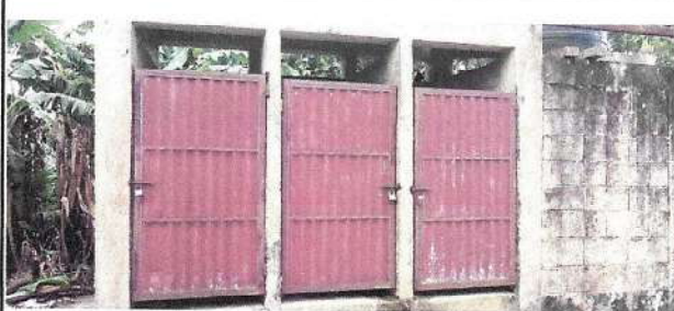
Foto 4: Sustitución de puertas metálicas.
