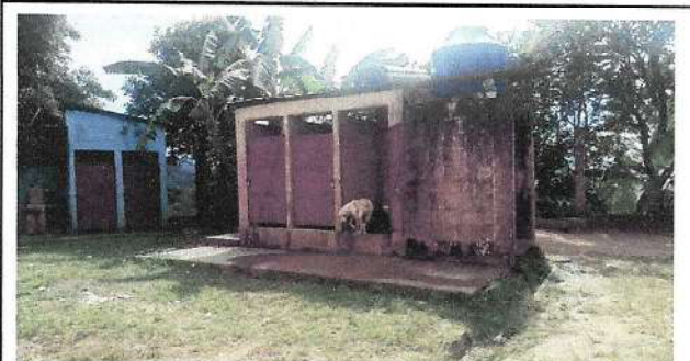
Foto 5: Sustitución de techo por terraza para instalación de tinaco para agua.
