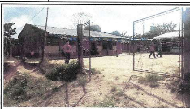
Foto 2: Sustitución y entechado de portón.
