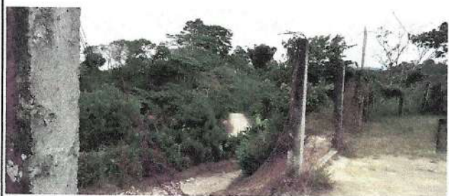
Foto 3: Reparación de muro perimetral.
