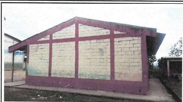
Foto1: Pintura en muros exteriores.
