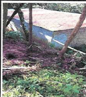
Foto 3: Reparación de muro perimetral
