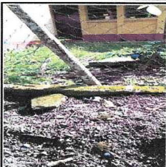
Foto 1: Reparación de muro perimetral
