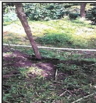
Foto 2: Reparación de muro perimetral
