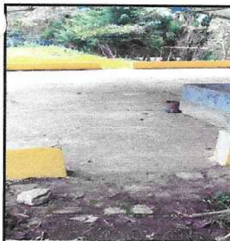
Foto 5: Reparación de planchas de concreto de patio.
