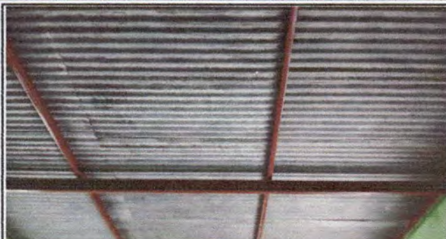
Foto 2: Estructura con la que actualmente cuenta el salón de clases.
