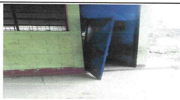
Foto 4: Sustitución de puerta antigua por apertura nueva de paneles
