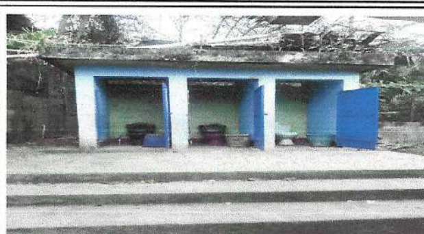
Foto 2 Sustitución de inodoros, azulejado y piso anti-deslizante en la parte de enfrente
