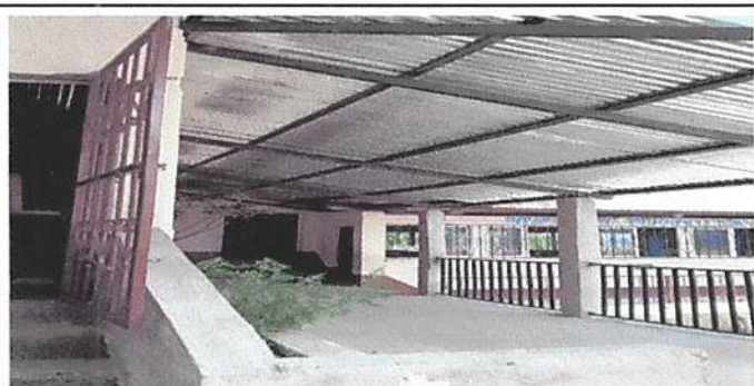
Foto1: COLOCACIÓN TECHO CORREDOR
