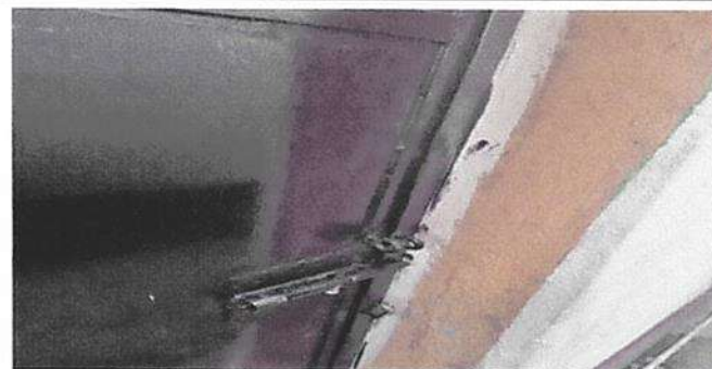
Foto 6: PUERTA DE COCINA
