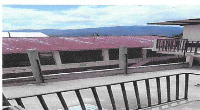
Foto 4: SUSTITUCIÓN DE MALLA
