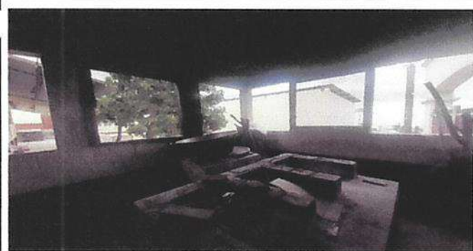
Foto 5: BALCONES DE COCINA
