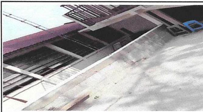
Foto 4: SUSTITUCIÓN DE MALLA
