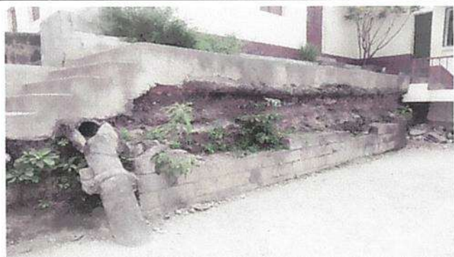
Foto 3: REPARACIÓN DE MURO
