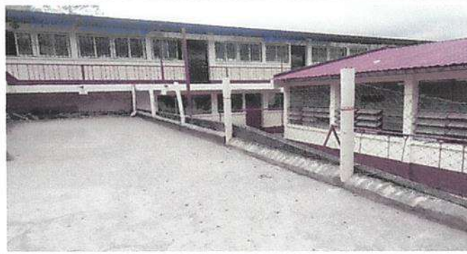
Foto 4: REPARACIÓN DE MALLA
