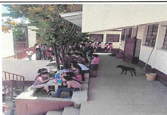
Foto 2: INSTALACIÓN DE BARANDAL
