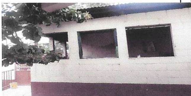
Foto 5: INSTALACIÓN DE BALCONES
