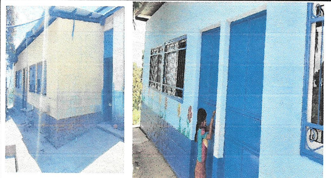
Foto 4: Sustitución de puertas
