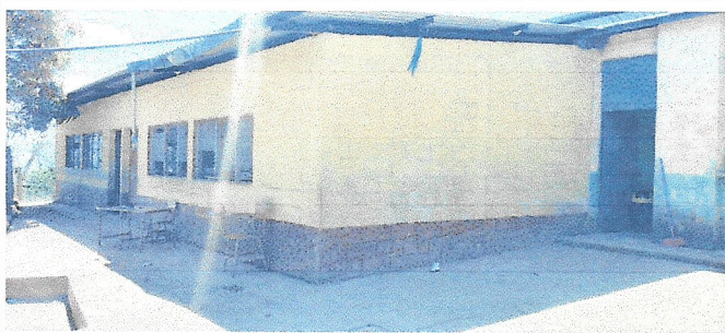
Foto 4: Sustitución de puertas
