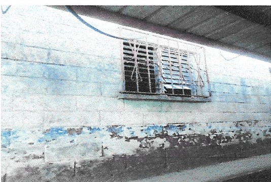
Foto 2: Pintura interior y exterior de aulas
