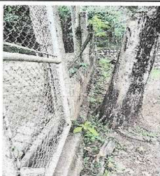
Foto 3: Sustitución de portón
