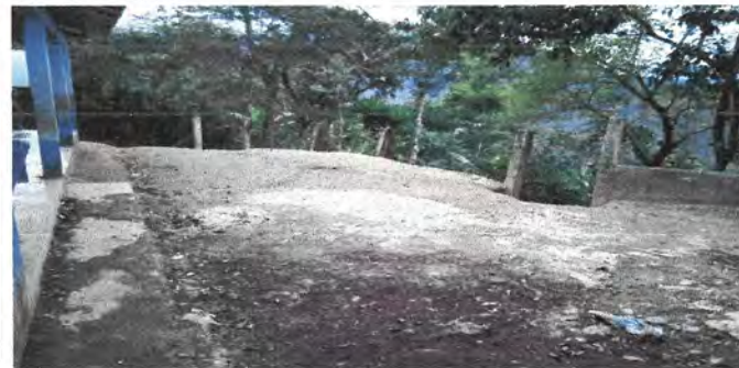
Foto 3: LOSA DE PATIO
