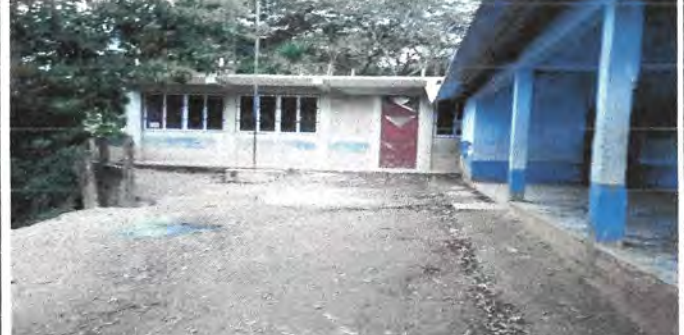
Foto 2: CONTINUACIÓN DE MURO
