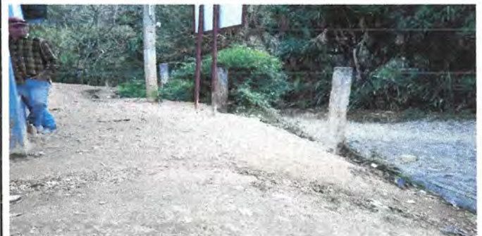
Foto 4: CONTINUACIÓN DE LOSA
