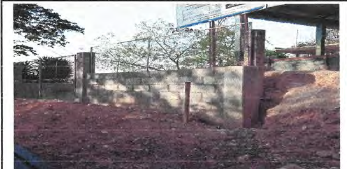
Foto 6: CONTINUACIÓN DE TECHO
