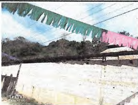
Foto 5: Sustitucion de lamina por lamina troquelada
