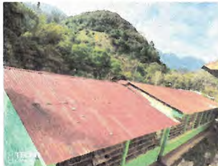
Foto 2: Sustitucion de lamina en mal estado por lamina troquelada alucin
