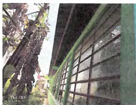
Foto 6: Sustitucion de metal por metal galvanizado
