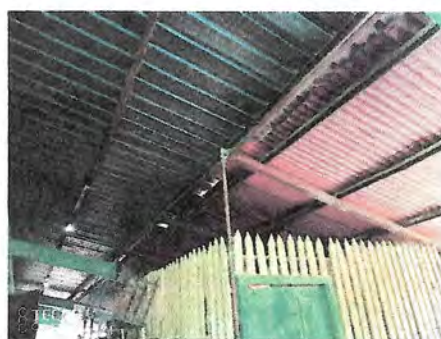
Foto 4: Sustitucion de metal por metal galvanizado
