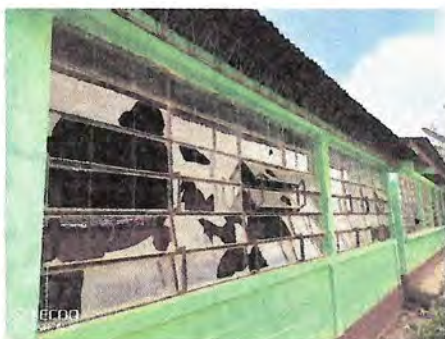
Sustitucion de balcon por ventana de metal
