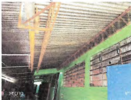
Foto1: Sustitucion de metal por metal
