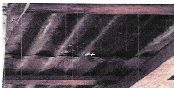
SUSTITUCION DE TECHO E INSTALACION DE ESTRUCTURA METALICA.
