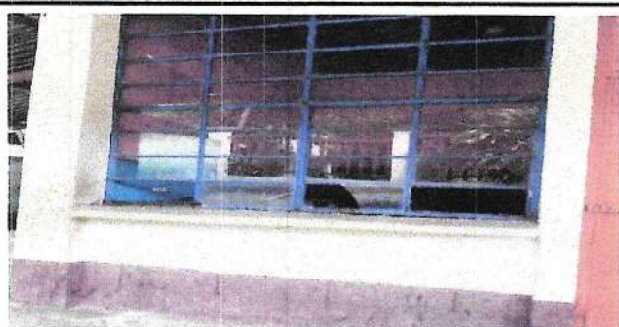
SUSTITUCION DE VENTANAS EN MAL ESTADO Y PINTURA DEL ESTABLECIMIENTO EN GENERAL.
