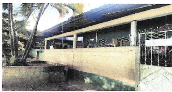
INSTALACION DE DE BALCONES.
