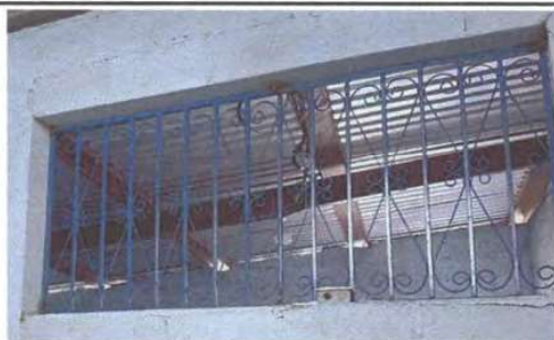
Foto 5: Mantenimiento de ventanas
