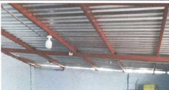
Imagen 1. Cubierta de Llamina
