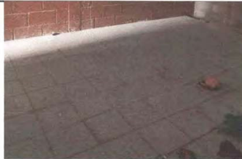
Imagen 4. Instalación de piso de granito
