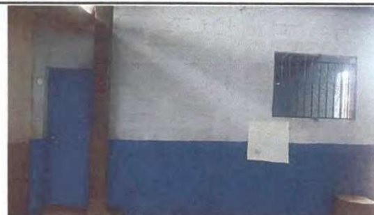
Foto 6: Ampliación de paredes de aula.
