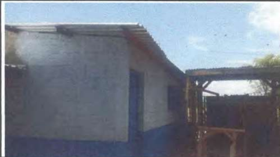
Foto 2: Ampliación de paredes de aula.
