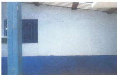
Imagen 3. Pintura en muros exteriores e interiores
