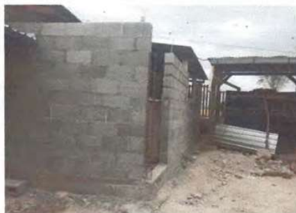
Foto 2: Ampliación de paredes de aula.
