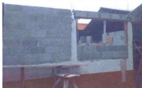
Foto 6: Ampliación de paredes de aula.
