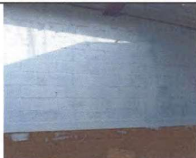
Imagen 3. Pintura en muros exteriores e interiores
