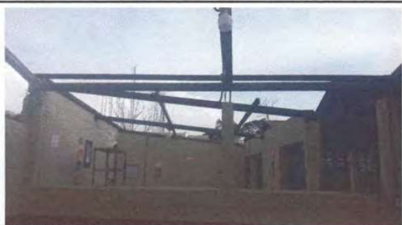
Imagen 1. Cubierta de Llamina
