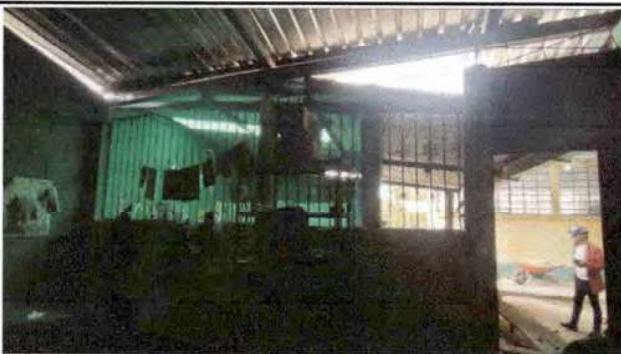
Foto 5: Mantenimiento de ventanas
