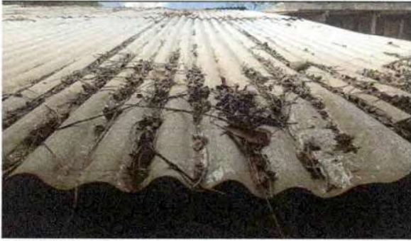
Imagen 1. Cubierta de Lámina
