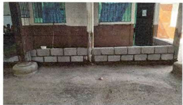
Foto 6: Ampliación de paredes de aula.
