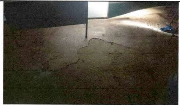
Imagen 4. Instalación de piso de cemento
