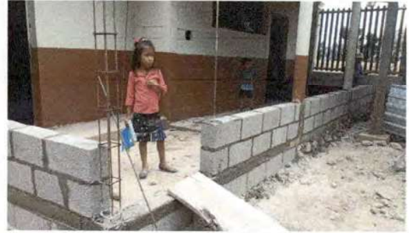
Foto 2: Ampliación de paredes de aula.
