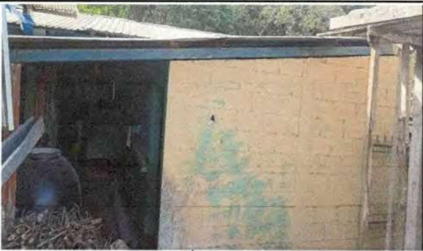
Imagen 3. Pintura en muros exteriores e interiores
