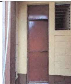
Foto 6: Mantemientos a puerta de metal
