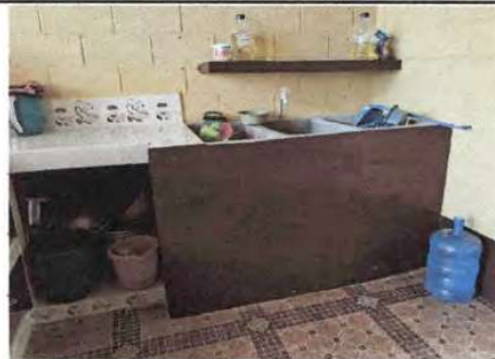
Imagen 2. Sustitución de pila de lavadero por pila de cemento
