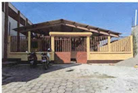
Imagen 3. Pintura en muros exteriores e interiores
