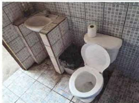
Imagen 4. Sustitución de Inodoro y sus accesorios
