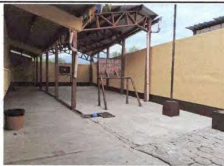
Foto 5: Ampliación de Muro Perimetral
