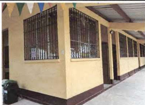
Imagen 1. Instalación y mantenimiento de balcones
