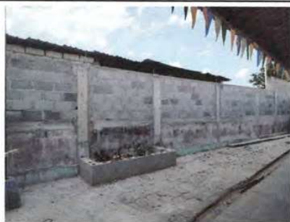
Imagen 3. Pintura en muros exteriores e interiores
