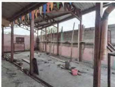
Foto 5: Ampliación de Muro Perimetral
