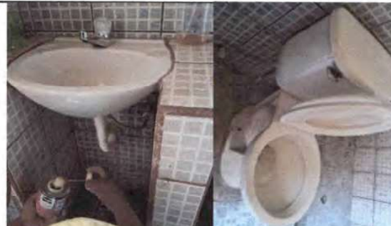
Imagen 4. Sustitución de Inodoro y sus accesorios
