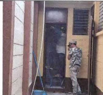
Foto 6: Mantenciones a puerta de metal
