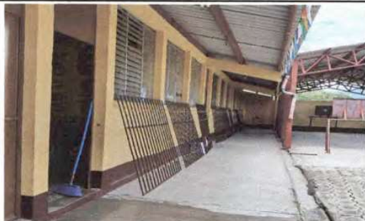
Imagen 1. Instalación y mantenimiento de balcones
