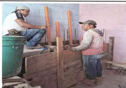
Imagen 2. Sustitución de pila de lavadero por pila de cemento
