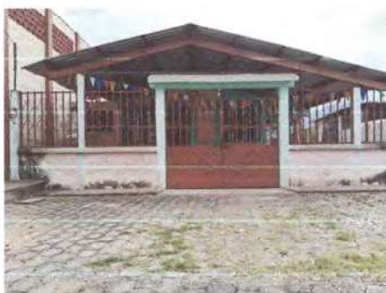
Imagen 3. Pintura en muros exteriores e interiores
