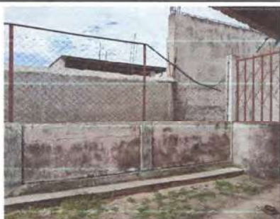
Foto 5: Ampliación de Muro Perimetral
