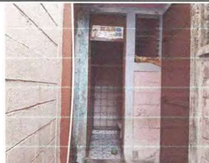
Foto 6: Mantemientos a puerta de metal
