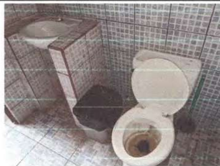
Imagen 4. Sustitución de Inodoro y sus accesorios
