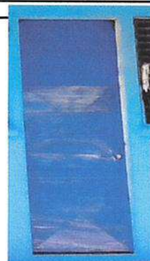
Foto 4: Sustitución de puertas.
