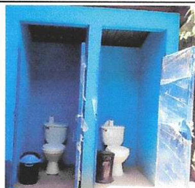
Foto 2: Sustitución de baño y repaación de puertas.
