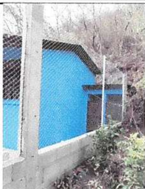
Foto 1: Reparación de muro con maya.
