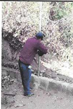
Foto1: Reparación de muro con maya.
