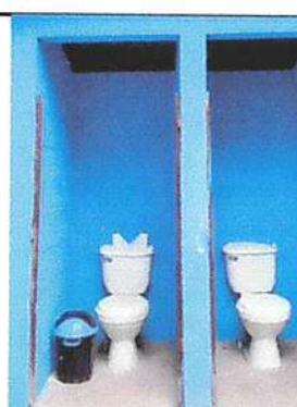
Foto 4: Sustitución de puertas.
