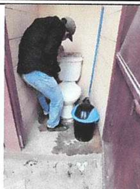
Foto 2: Sustitución de baño y repaación de puertas.
