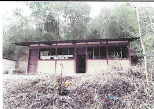
Foto 6: Pintura en interior y exterior.
