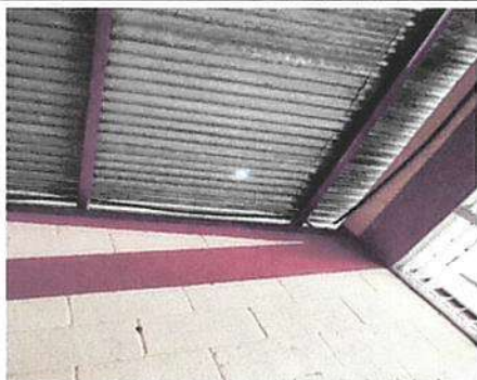
Foto 3: Sustitución de lámina.
