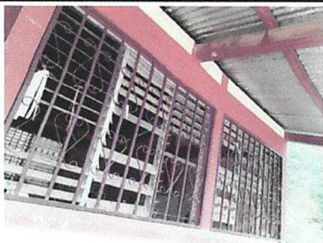
Foto 5: Sustitución de ventanas.
