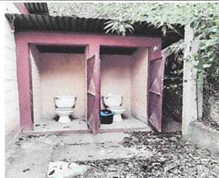
Foto 2: Sustitución de baño y repaación de puertas.
