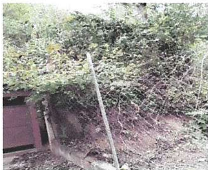
Foto 1: Reparación de muro con maya.
