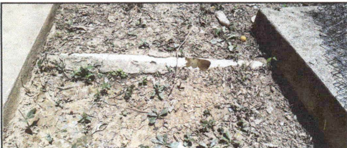
Foto 3: Sustitución de tubo de drenaje de aguas negras
