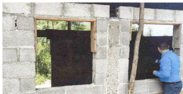
Foto 6: colocación de ventanas y puerta en cocina.
