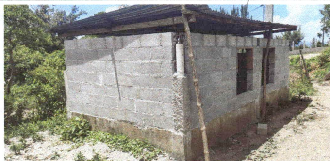
Foto 5: Sustitución de estructura de techo y cambio de lamina en cocina.
