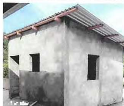
Foto 4: Reparación de cocina, ampliación de paredes sustituyendo madera por block, sustitución de lámina de zinc por troquelada Alucín.
