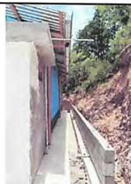
Foto 6: Instalación de canales de PVC y bajadas de agua y repación de cuneta por cuneta de concreto con protección de block.
