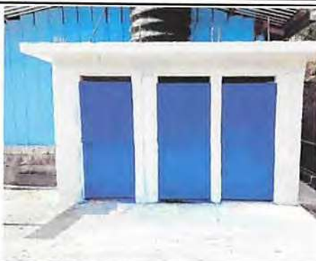
Foto1: Sustrucción de sanitarios.
