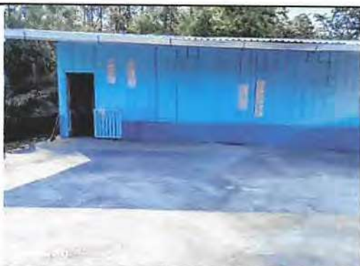
Foto 3: Pintura de paredes y zócalo, ampliación de losa de patio
