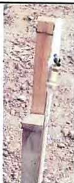
Foto 5: Reparación de red de agua potable.
