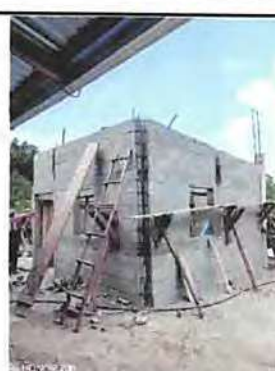
Foto 4: Reparación de cocina, ampliación de paredes sustituyendo madera por block, sustitución de lámina de zinc por troquelada Alucín.
