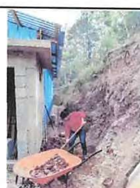
Foto 6: Instalación de canales de PVC y bajadas de agua y reparación de cuneta por cuneta de concreto con protección de block.
