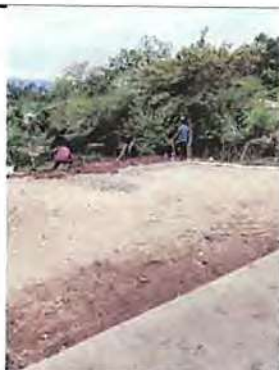
Foto 5: Reparación de red de agua potable.
