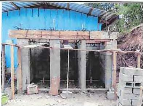
Foto1: Sustitución de sanitarios y ampliación de pared sustitución de madera.
