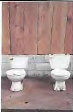
Foto1: Sustitución de sanitarios y ampliación de pared sustituyendo madera.
