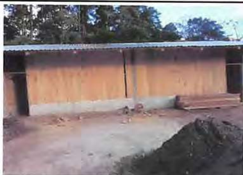
Foto 3: Pintura de paredes y zócalo, ampliación de losa de patio
