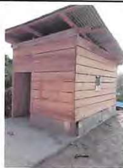
Foto 4: Reparación de cocina, ampliación de paredes sustituyendo madera por block, y sustitución de lámina de zinc por troquelada Alucinc.
