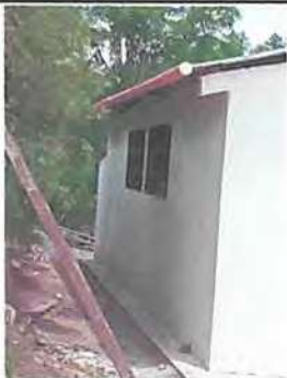
Foto 5: Instalación de canales de PVC.
