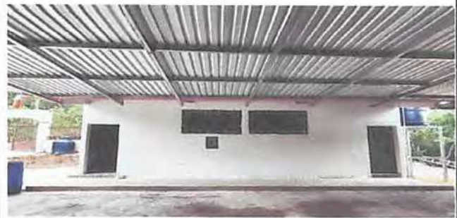
Foto 6: Cernido y repellado de paredes
