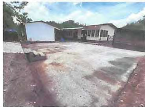
Foto 4: Ampliación de losa de patio.
