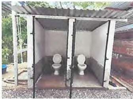
Foto 3: Sustitución de letrinas por sanitarios de cerámica, instalación de tinaco de agua y sustitución de puertas por puertas de madera.
