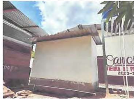
Foto 2: Sustitución de techo y reparación de pared.
