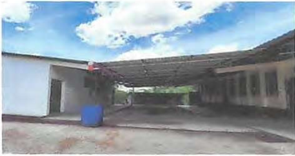
Foto1: Sustitución de lámina.
