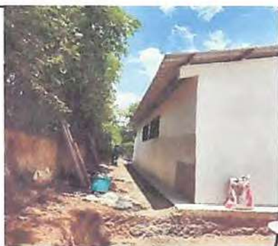
Foto 5: Instalación de canales de PVC.
