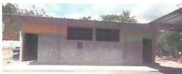
Foto 6: Cernido y repellado de paredes
