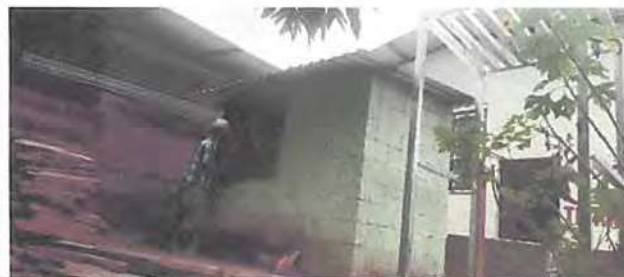
Foto 2: Sustitución de techo y reparación de pared.
