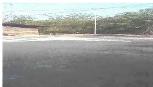
Foto 4: Ampliación de losa de patio.
