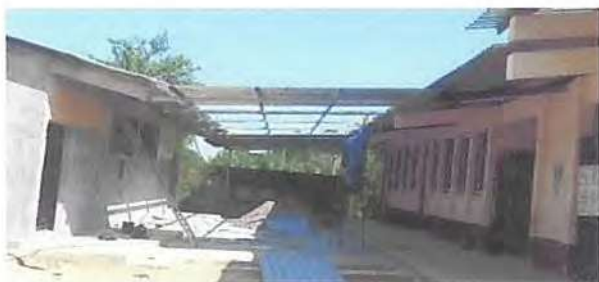
Foto1: Sustitución de lámina.
