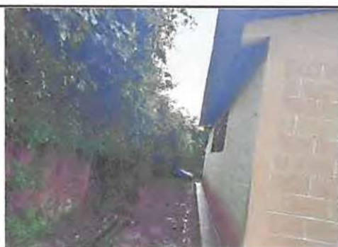
Foto 5: Instalación de canales de PVC.
