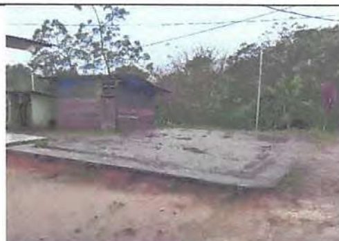
Foto 4: Ampliación de losa de patio.
