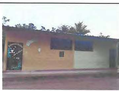
Foto 6: Cernido y repellido de paredes
