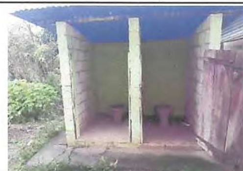
Foto 3: Sustrucción de letrinas por sanitarios de cerámica, instalación de tinaco de agua y sustitución de puertas por puertas de madera.
