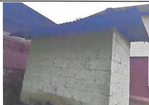
Foto 2: Sustrucción de techo y reparación de pared.
