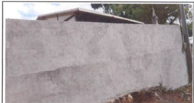
Foto 4: Reparación de muro perimetral
