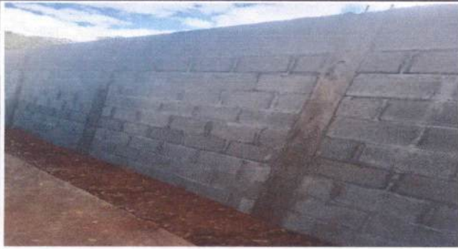
Foto 1: Reparación de muro perimetral
