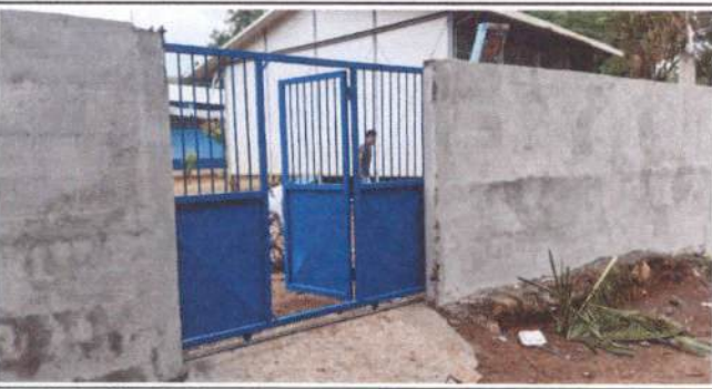
Foto 5: Sustitución de portón
