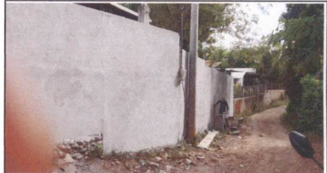
Foto 2: Reparación de muro perimetral
