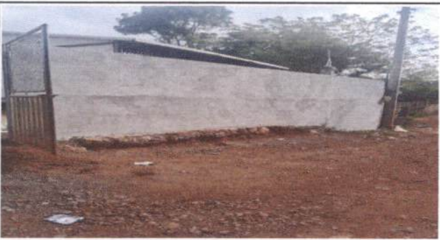
Foto 3: Reparación de muro perimetral
