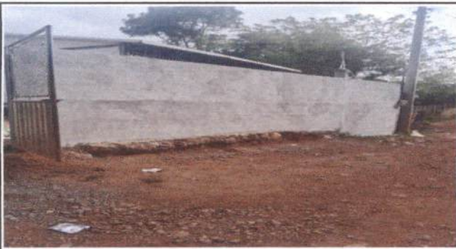
Foto 3: Reparación de muro perimetral
