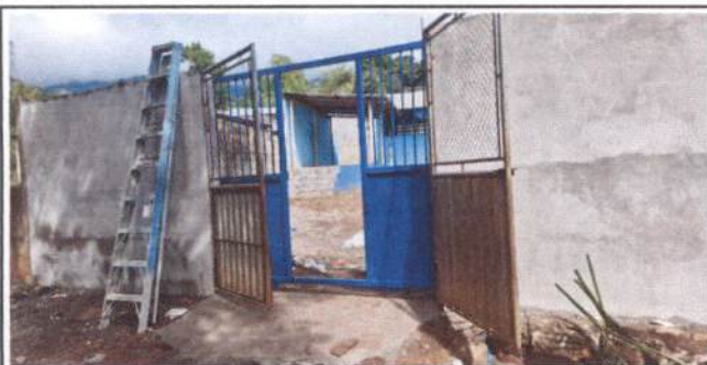
Foto 5: Sustitución de portón
