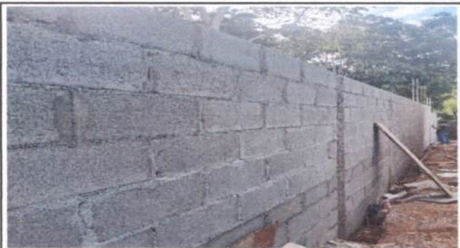
Foto 4: Reparación de muro perimetral
