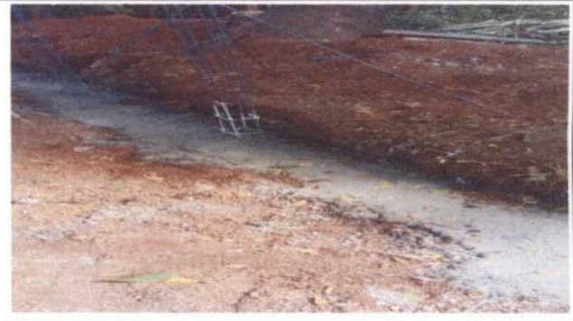
Foto 2: Reparación de muro perimetral
