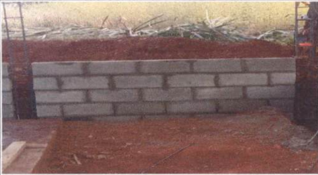
Foto 1: Reparación de muro perimetral
