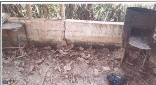
Foto 1: Reparación de muro perimetral
