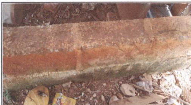
Foto 3: Reparación de muro perimetral
