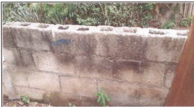
Foto 4: Reparación de muro perimetral
