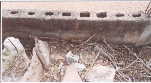
Foto 2: Reparación de muro perimetral
