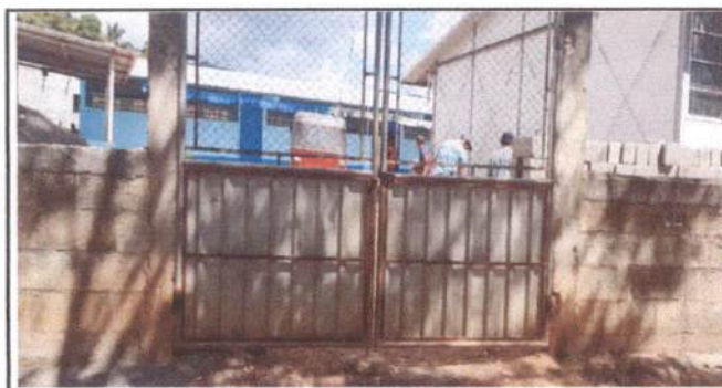
Foto 5: Sustitución de portón
