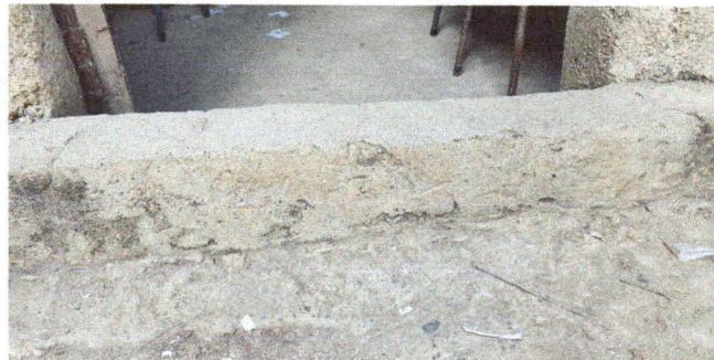
Foto 6: Mejoramiento de muro existente
