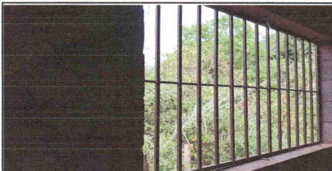
Foto 5: Remodelación de ventana 1
