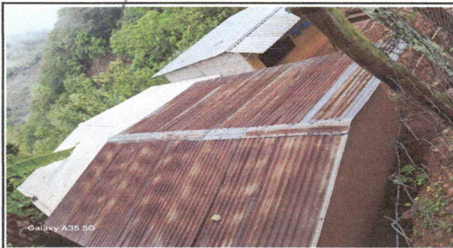
Foto 9: Sustitución de lamina antigua por lamina troq. Cal. 26
