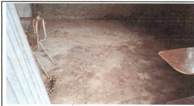
Foto 10: Instalación de piso cerámico aula 2
