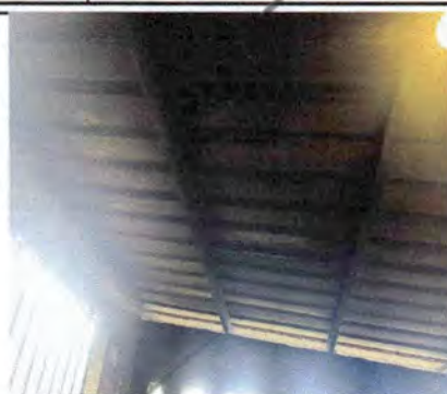
FOTO. 2 Sustrucción de estructura de soporte de madera por metal.
