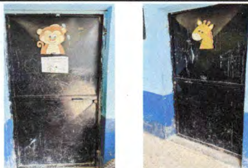
FOTO. 3 Mantenimiento de puertas y cambio de chapa.
