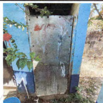
FOTO. 4 Sustrucción de puerta de servicio sanitario.
