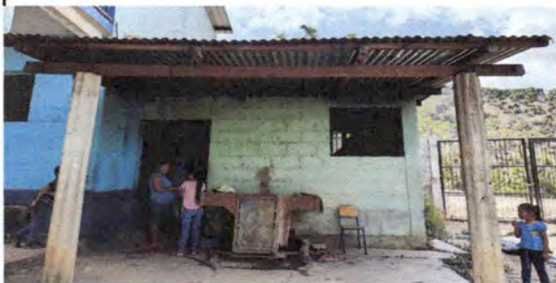
FOTO 9. Reparación y ampliación de cocina
