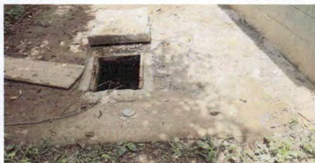
FOTO 8. Reparación y mantenimiento de cisterna de concreto
