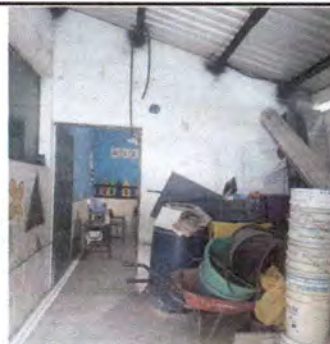
FOTO 12. Seguimiento y refuerzo de pared
