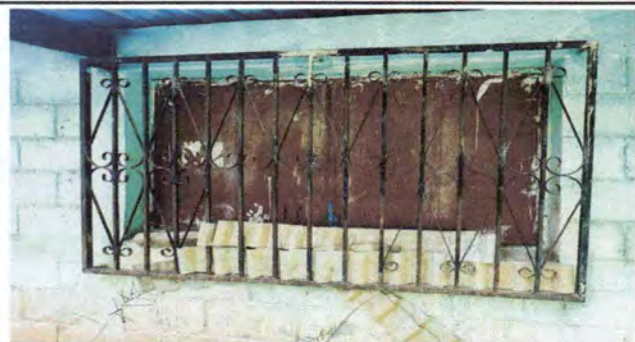
FOTO 5. Mantenimiento de ventanas y balcones
