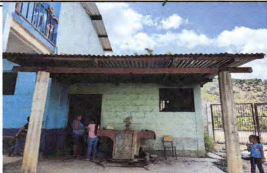
FOTO . 1 Sustrucción de lámina por lamina troquelada en cocina y baño.
