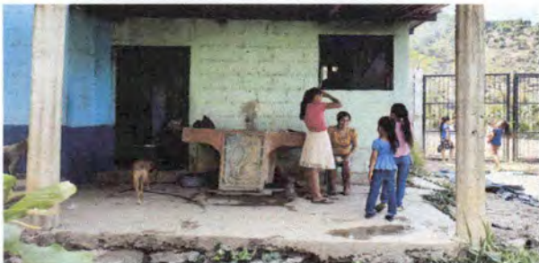
FOTO 7. Sustrucción de la losa de patio por piso de granito
