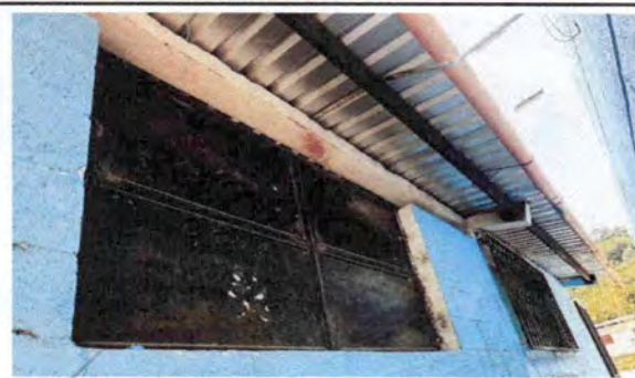
FOTO 6. Instalación de balcones.
