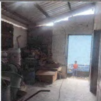
FOTO 11. Seguimiento y refuerzo de pared
