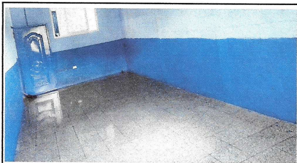
Imagen 4. instalación de piso de granito
