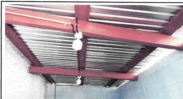
Foto 6: Instalación de cableado eléctrico.
