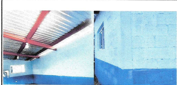
Foto 2: Seguimiento y reforzamiento de paredes de aula existentes; y pintura en interiores en interior y exterior
