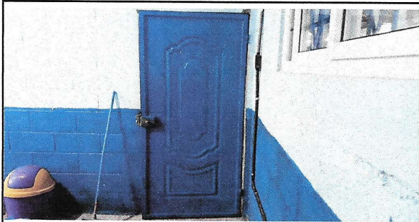
Imagen 3. Instalación de puerta.
