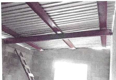
Imagen 1. Cubierta de Llamina
