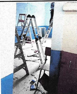
Imagen 3. Instalación de puerta.
