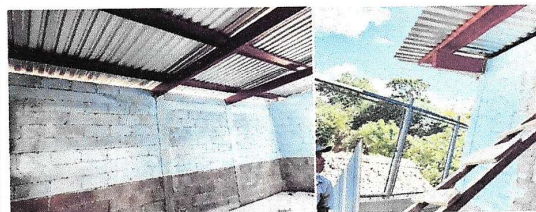
Foto 2: Seguimiento y reforzamiento de paredes de aula existentes; y pintura en interiores en interior y exterior
