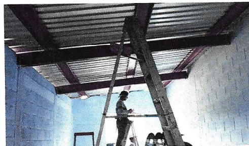
Foto 6: Instalación de cableado eléctrico.
