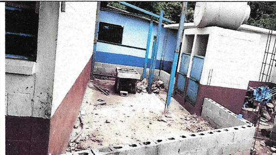
Foto 2: Seguimiento y reforzamiento de paredes de aula existentes; y pintura en interiores en interior y exterior
