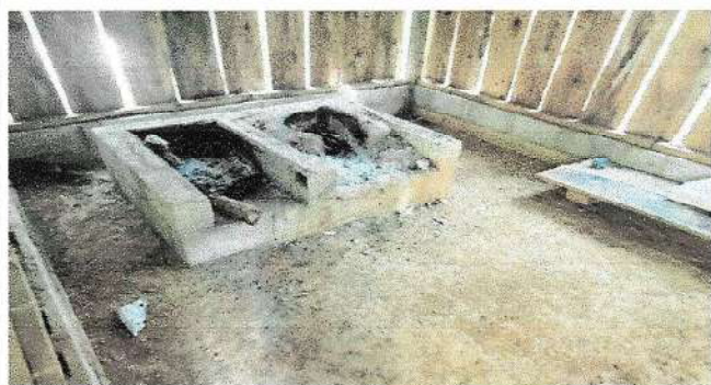
Foto1: Reparación muro perimetral cocina.
