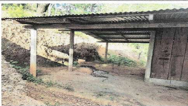
Foto 4: Sustitución de lámina.
