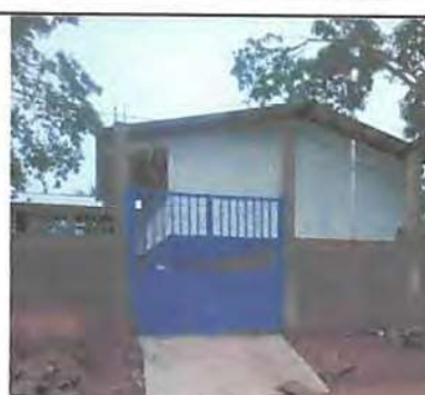
Foto 4: Sustrucción de portón, instalación de estructura de techo, sustitución de gradas por rampa.
