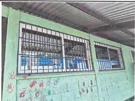
Foto1: Sustrucción de ventanas por ventanas corredizas de PVC e instalación de balcones.
