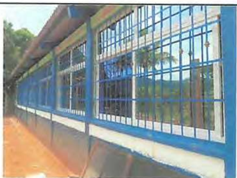
Foto 3: sustitución de ventanas de paleta por ventanas corredizas de PVC e instalación de balcones.
